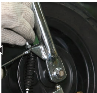
ハンドル周りを移植するのでブレーキワイヤーも外しておきます
